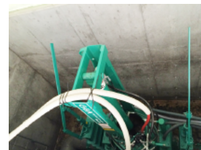
⑥糞尿搬送ポンプ(マグナムポンプ)
